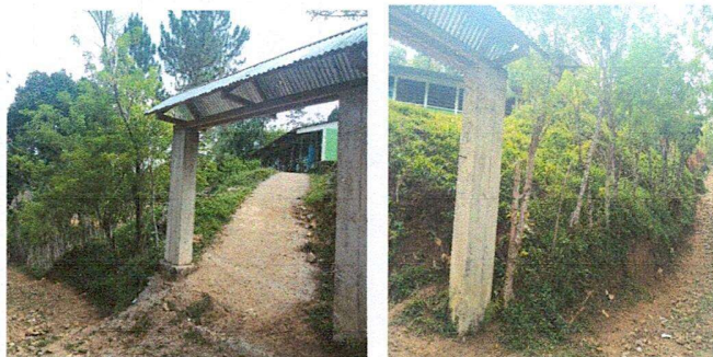
Foto 3: Sustrucion del cerco perimetral
