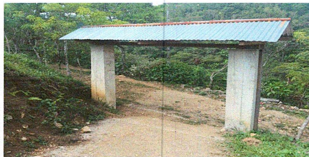
Foto 2: Colocacion un porton.
