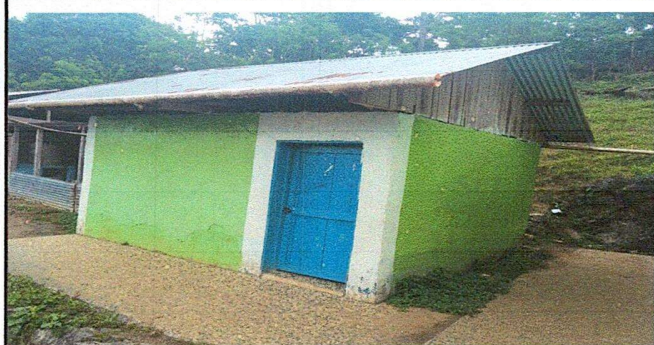
Foto 1: Sustrucion la estructura de techo.
