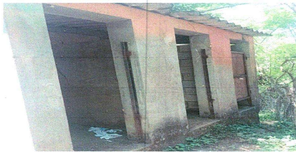
Foto 6: Colocacion de puerta del sanitario y sustrucion la estructura del techo
